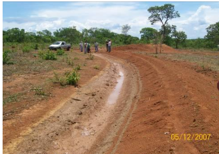
Figura 14: Exemplo de terraço executado
