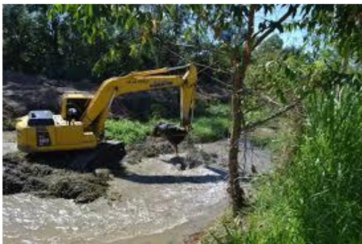
Figura 18: Remoção de sedimentos e macrófitas
