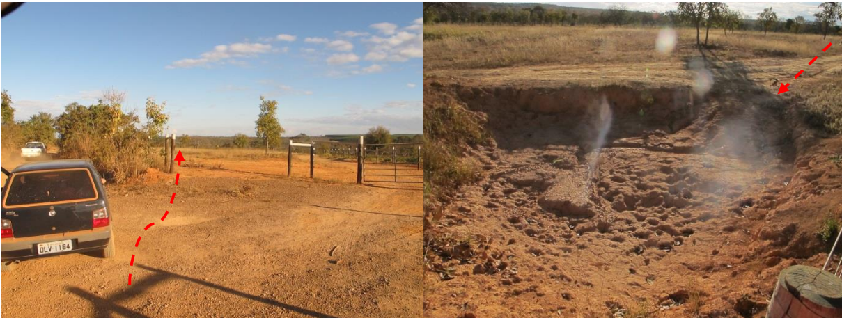
Foto 1: Local definido para construção bigode (Coord. UTM 552073 / 7931350)
