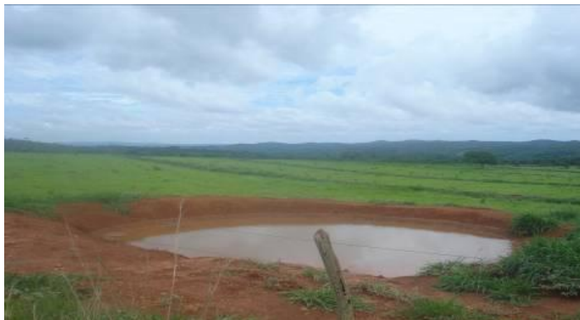
Figura 13: Exemplo de barraginha
